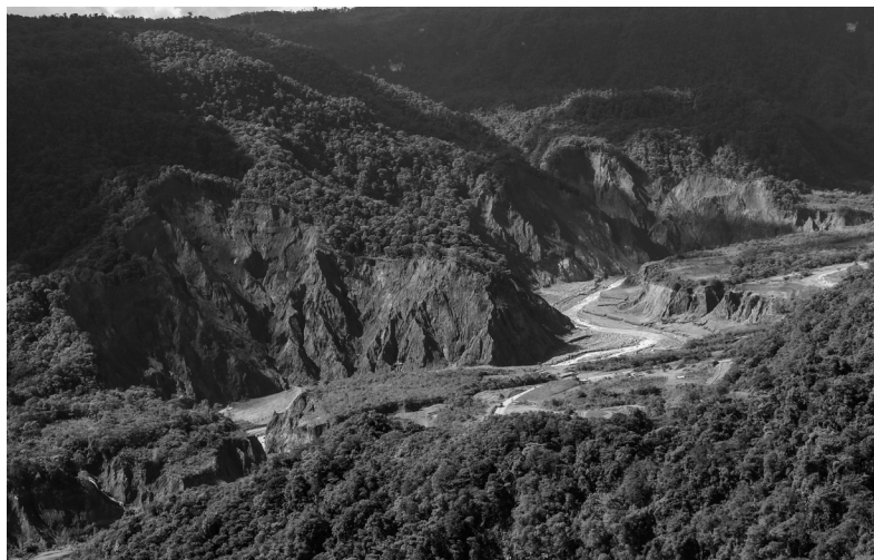
La erosión regresiva en el Río Coca, pone en grave riesgo a las comunidades de las riberas y a la infraestructura hidroeléctrica. Fuente: Acción Ecológica.
