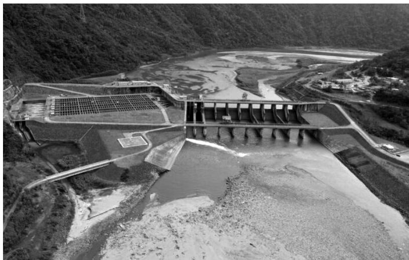
Coca Codo Sinclair presentó procesos de sedimentación, erosión y hundimientos de tierra. Foto: El Comercio
